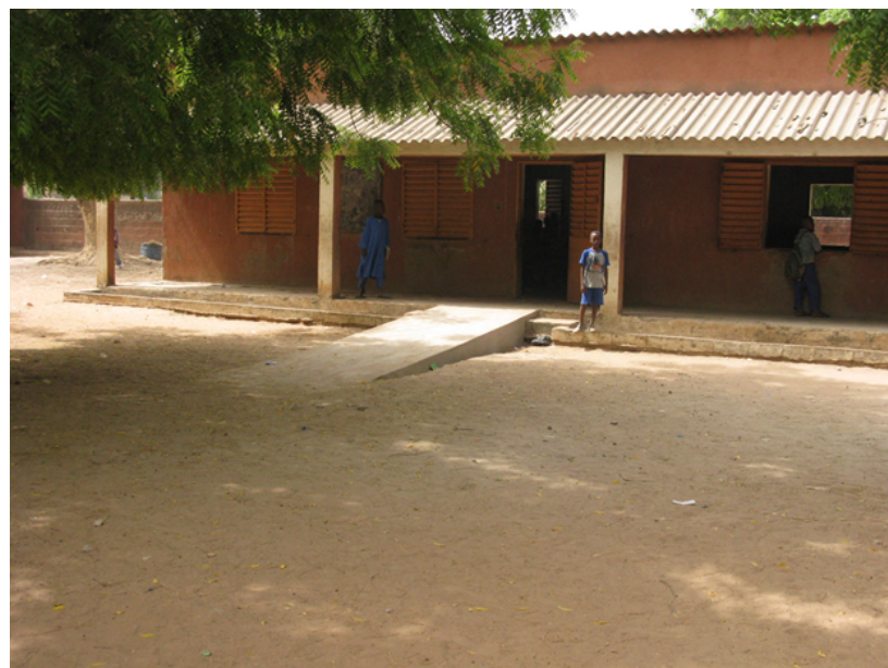
Légende : Photos 1 et 2 : Aménagement de rampes d'accès sur des bâtiments déjà existants dans une école de Kolda (Sénégal) Crédits photos : Aïssata SANE
